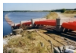
3-fasede vandrør på 750 m !
