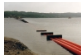
Rørene fyldes med vand og synker ned på bunden af fjorden
