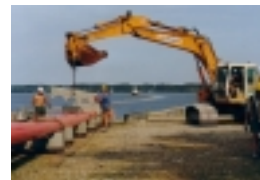
Ballastblokke monteres på de tre PE-rør
