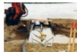
Et kabel er trukket, et andet er på vej ud af røret i midten.
