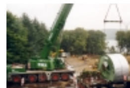
Tromlerne med søkabler vejer 23 tons
